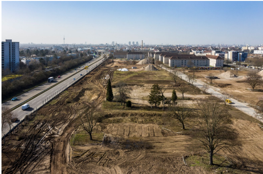
Rückbau der Lärmschutzwand auf Columbus © MWSP/Annette Mück
