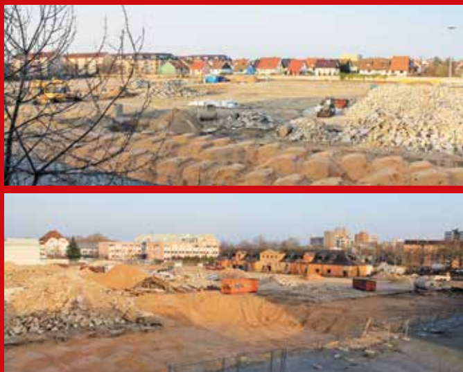
Im nordöstlichen Bereich des Turley Areal ist der Rückbau nahezu abgeschlossen. Hier beginnt in Kürze die Entwicklung.
